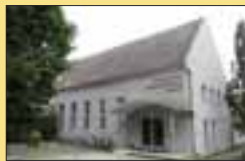
Die Kirche ist vollständig barrierefrei.
